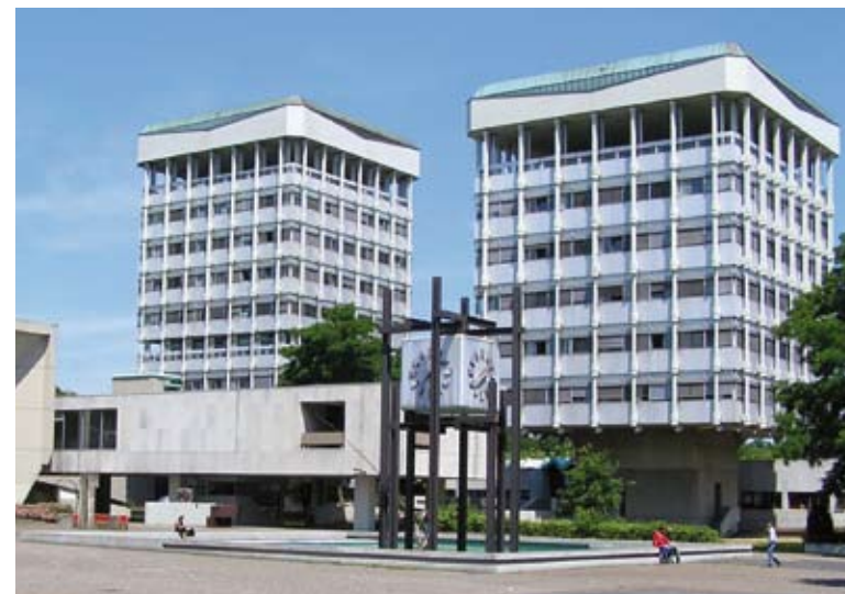
Die Dezernatstürme des Rathauses der Stadt Marl, deutliches Abbild eines städtebaulichen Konzepts der 60er Jahre, in denen sich Marl ein zeitgemäßes Zentrum zulegte. Heute sind die Bauten vielfach sanierungsbedürftig.
